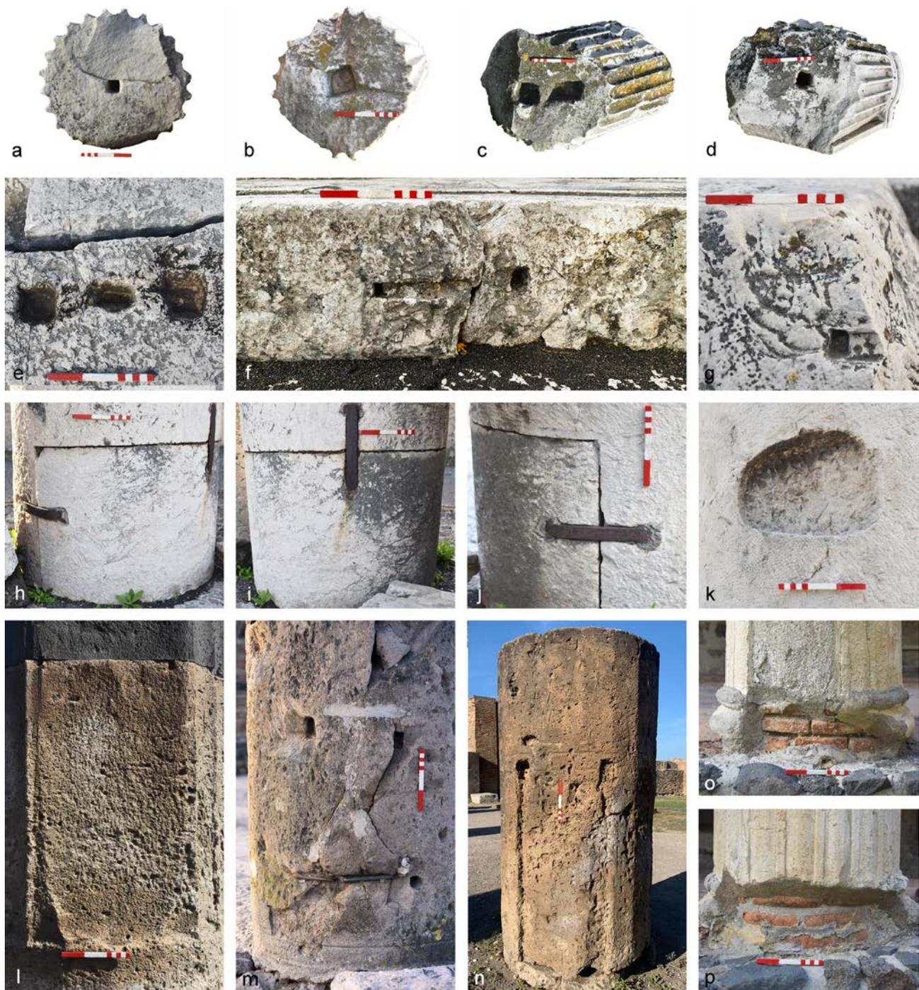
Fig. 6a-p. Pompei: restauri delle strutture trilitiche degli edifici pubblici: a-d. Edificio di Eumachia; e-k. portico occidentale del Foro; l-n. cosiddetto Portico di Popidio; o-p. Palestra Grande (foto A.).
